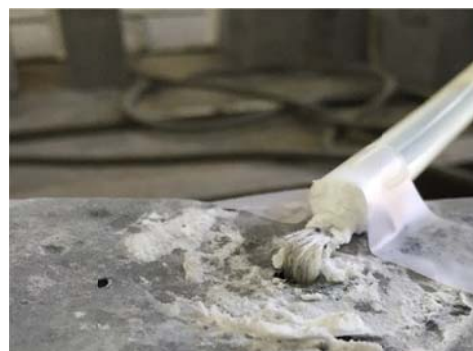
Fig. 4 Failure of D20
