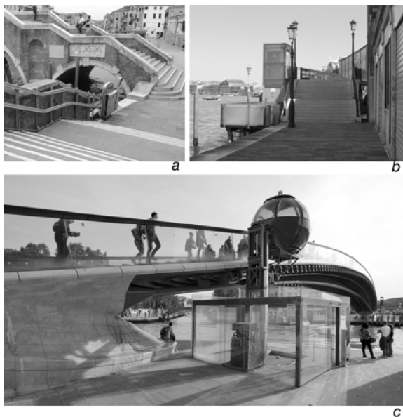
Fig. 2 Mechanical systems: a. An example of stair-lift at the Ponte de la Saponeta ; b. Elevators at the Ponte Longo ; c. "ovovia" on the Ponte della Costituzione
