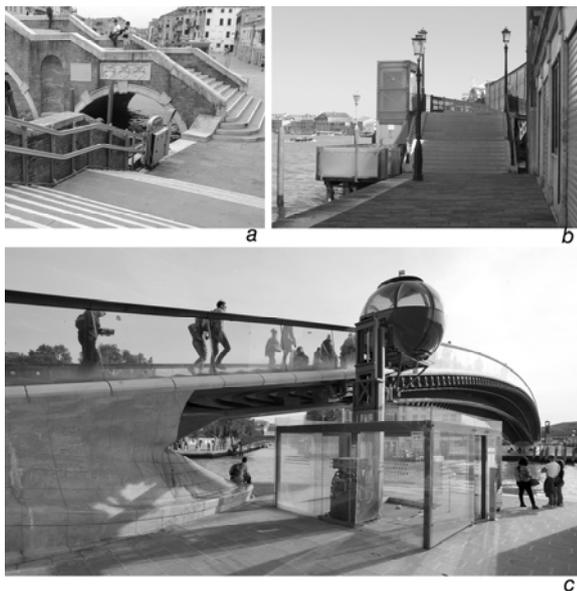
Fig. 2 Mechanical systems: a. An example of stair-lift at the *Ponte de la Saponeta*; b. Elevators at the *Ponte Longo*; c. "ovovia" on the *Ponte della Costituzione*
