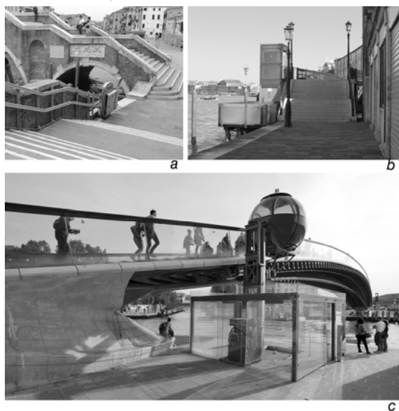
Fig. 2 Mechanical systems: a. An example of stair-lift at the Ponte de la Saponeta ; b. Elevators at the Ponte Longo ; c. "ovovia" on the Ponte della Costituzione
